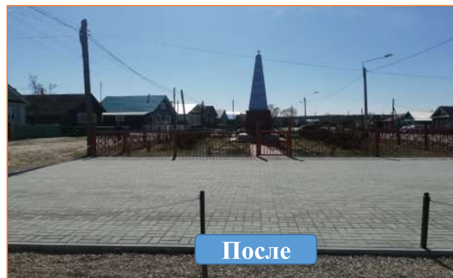
Ремонт обелиска в честь воинов погибших в ВОВ 1941-1945 г.г. с. Шилокша
