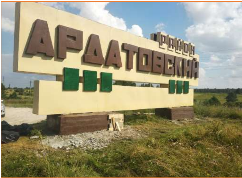
Ремонт указателя при въезде в гог Кулебаки
